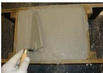
Fig. 5.35 - Nivelamento da argamassa
