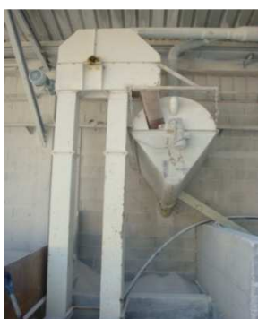
Fig. 4.19 - Processo de crivagem do agregado
