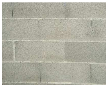
Fig. 4.4 - Paredes de blocos de cimento
