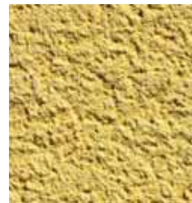
Fig. 4.9 - Acabamento “Gota, Tirolésa ou Rústico”
