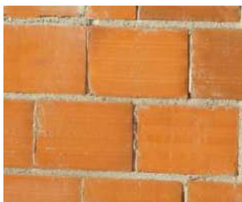
Fig. 4.3 - Paredes de tijolo cerâmico
